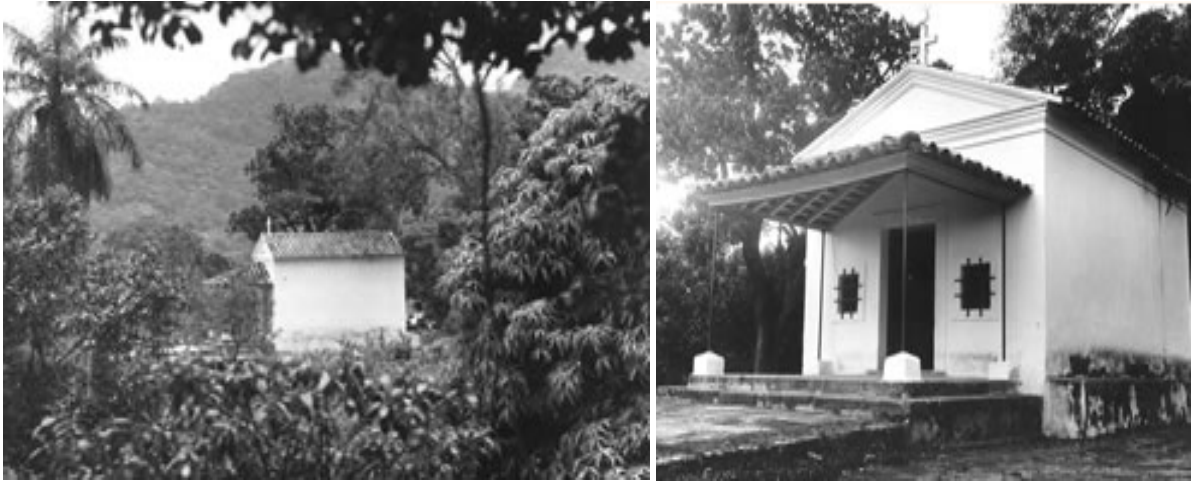
Registro fotográfico da capelinha em 1962 (esquerda) e 1961, com o alpendre apoiado em montantes metálicos 37 .
