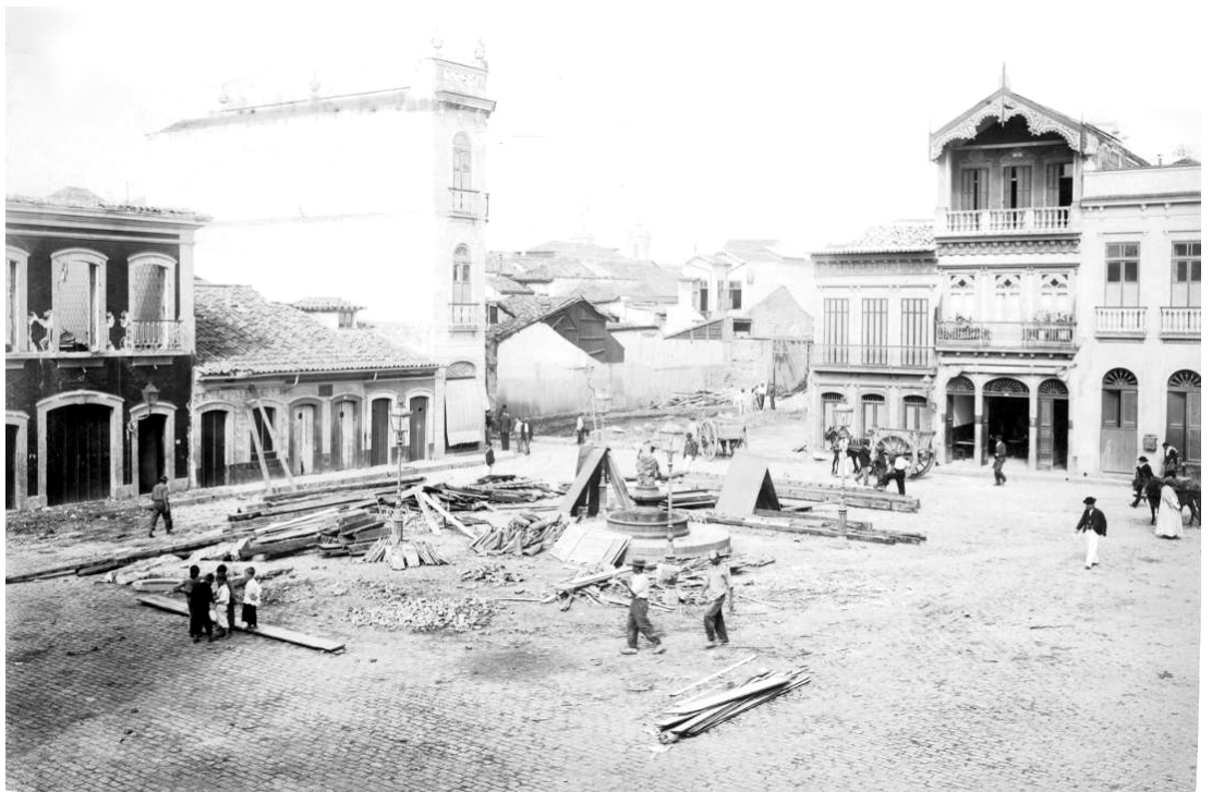
Figura 10: Largo de São Domingos durante las obras de la Rua do Sacramento (1903). Con la apertura de la Av. Presidente Vargas, el Largo desapareció. Fuente: Archivo Histórico del Museo de la República (fotografía de Augusto Malta).
