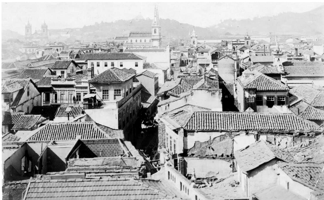
Figura 7: Rua do Sacramento: vista panorámica en dirección a la Praça Tiradentes antes de las obras de prolongación (1903).
