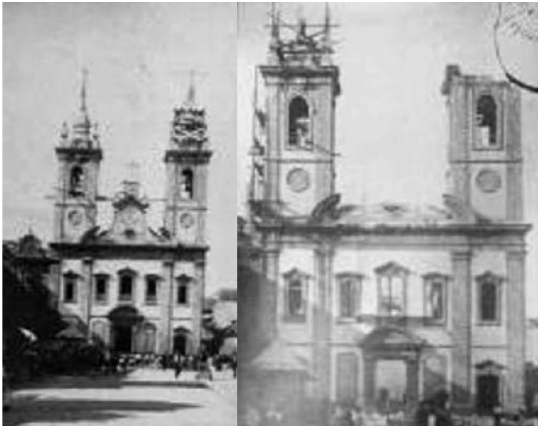
Figura 9: Igreja de São Joaquim antes y durante la demolición para la prolongación de la Rua do Sacramento y el ensanchamiento de la Rua Marechal Floriano y Camerino (1903). Archivo Histórico del Museo de la República
