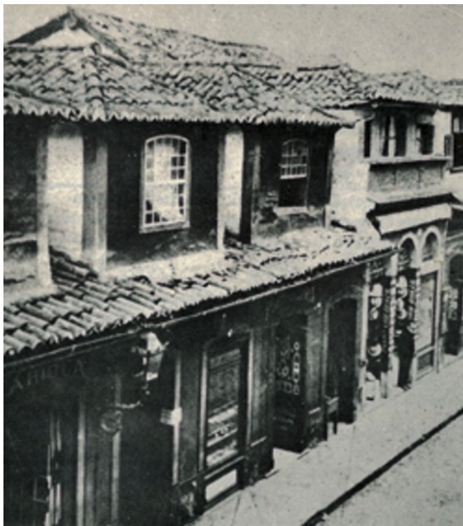
Figura 1: Tipo de construção da Cidade antes da Reforma Urbana: Rua da Carioca antes das demolições em 1904.
