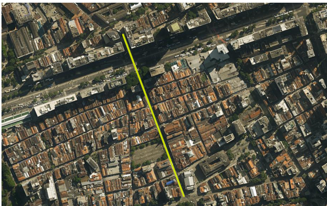
Figura 19: Avenida Passos destacada em ortofoto de 2024. Nota-se a interrupção em seu traçado com a abertura da Av. Presidente Vargas. Nota-se também que muitos dos imóveis situados em ambos os lados do logradouro foram preservados de alguma forma, dado o tipo de telhado e a metragem do imóvel. Nesse sentido, a paisagem da Av. Passos manteve-se muito mais estável que a da Av. Rio Branco. Fonte: Instituto Municipal de Urbanismo Pereira Passos
