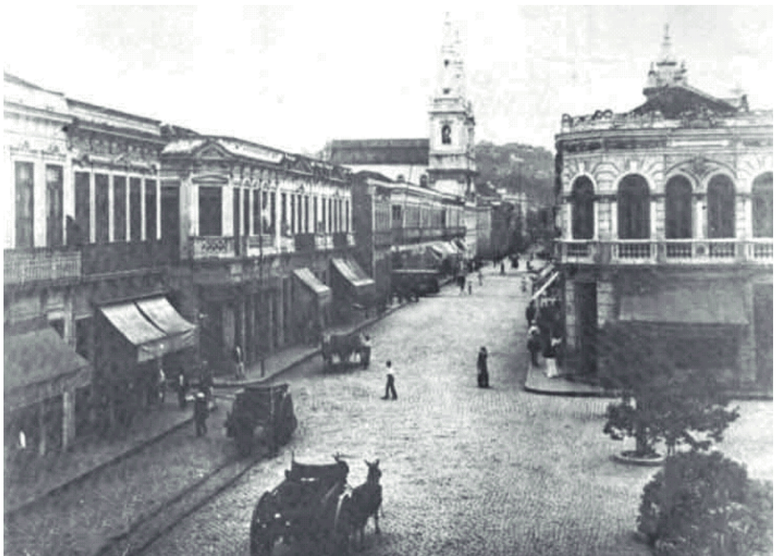
Figura 14: Rua do Sacramento e Largo de São Domingos depois das obras (1905). Fonte: Arquivo Geral da Cidade do Rio de Janeiro (foto de cartão postal, sem informação de autoria)
