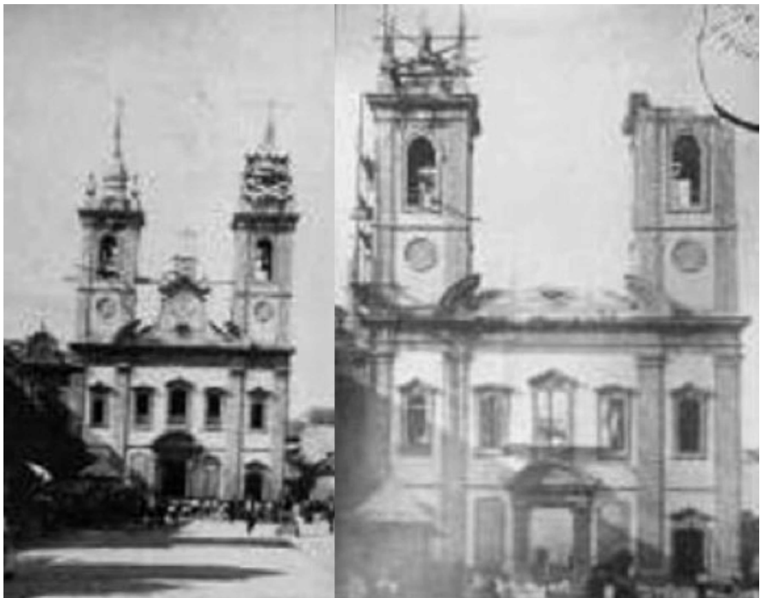
Figura 9: Igreja de São Joaquim antes e durante a demolição para o prolongamento da Rua do Sacramento e alargamento da Rua Marechal Floriano e Camerino (1903).
